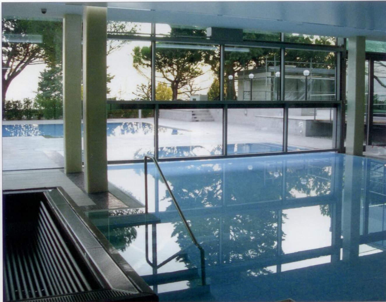
Depuis la piscine intérieure, aucun obstacle visuel ne vient perturber la vue lorsque la baie disparaît intégralement dans le sol. Fermée, elle cadre le paysage. BITZ&SAVOYE
